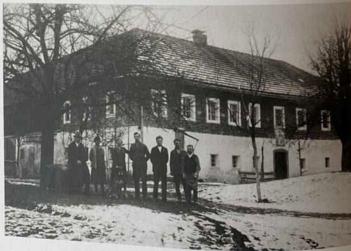
Beispiel für einen Ausbau des alten Hofes: der alte ebenerdige Wohntrakt (kleine Fenster!) wurde in Sichtziegelbauweise (große Fenster) aufgestockt. „Steinmayrhaus“, Gemeinde Behamberg.
